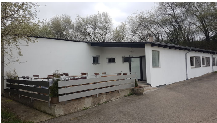
Außenbereich (mit Terrasse und Parkplätzen)
